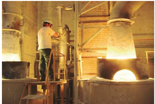
Brazinco - forno de fusão de zinco
